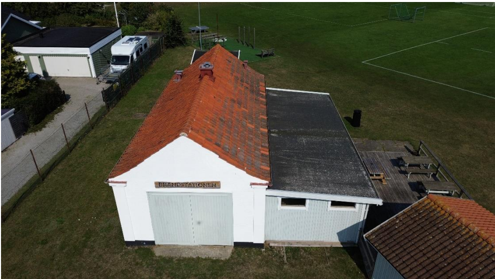
Flygvy från söder. Brandstationen har takbeläggning av enkupigt rött vingtegel. Tillbyggnaden har ett papptäckt pulpettak.
