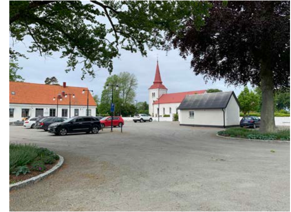
Vy över delar av församlingshemmet och Östra Torps kyrka.
