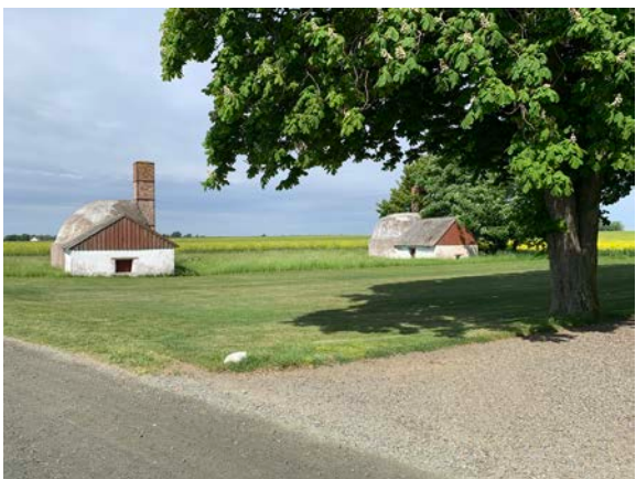
Vy mot nordväst. Längs Tånevägen ligger fyra kalkugnar intill en utskiftad gård.
