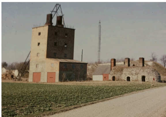
Ernst Knutssons trippelugn och femvåningsugnen som aldrig färdigställdes. Foto 1978. Kupolugnarna renoverades 1973. En militäranläggning uppfördes på slagghögen, numera plomberad. Källa: Jan, Jönsson (2023). Sydligast. Boken om Smyge. Platsen, människorna och historierna.
