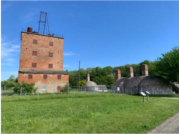
Vy mot norr. Murbruksfabriken kom aldrig i bruk. Intill finns fyra kupolkalkugnar.
