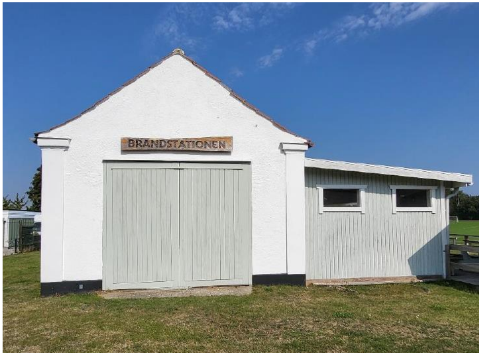
Bild på f.d. brandstation. Vita putsfasader med något grov ytstruktur, svart sockel, och slätputsad dekor i form av hörnpilastrar och takfotslistor. Sadeltak med något svängda takfall, gavlar utan taksprång, och takbeläggning av enkupigt rött vingtegel. Portar och dörrar utgörs av enkla bräddörrar av trä.
