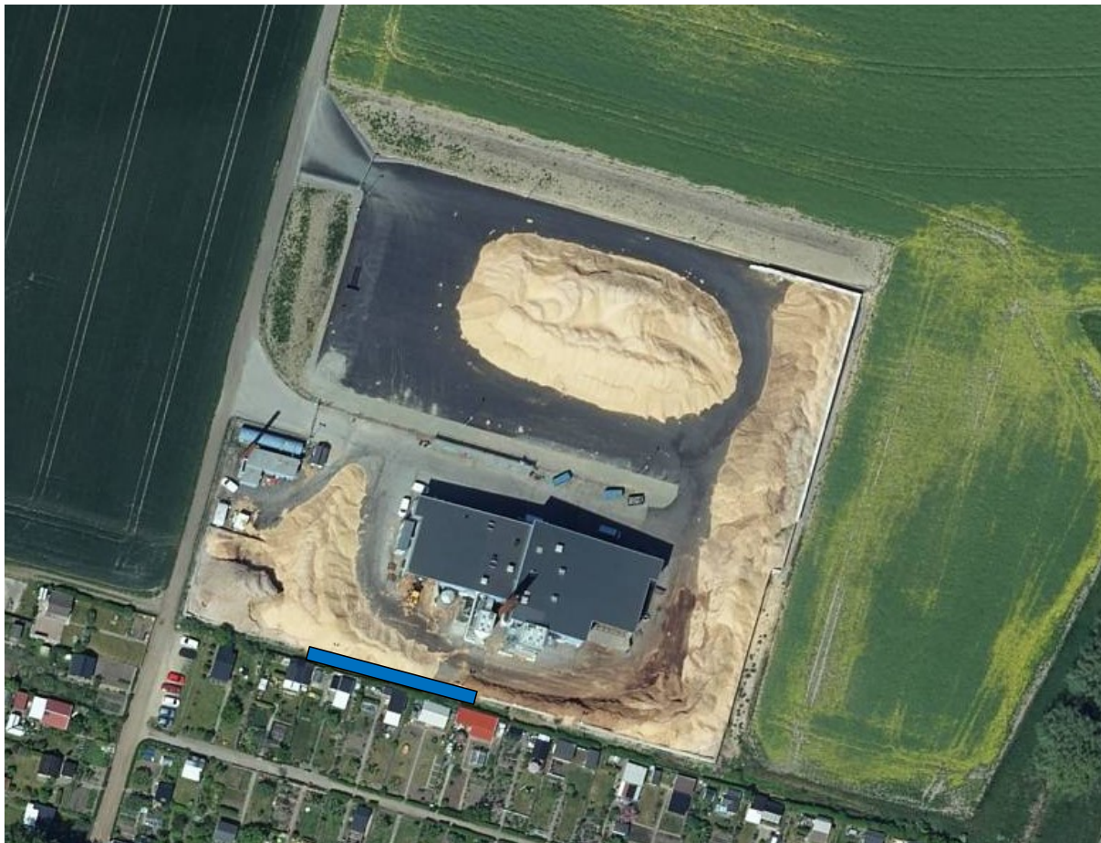
Figur 3.5. Flygbild med skiss i blått över den del där muren behöver kompletteras för att skapa en släckvatteninvalning. Flygfotot är hämtat från Eniro.
