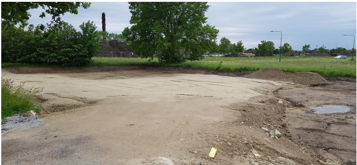
Figur 5.5 visar pågående utläggning av återfyllningsmaterial.
