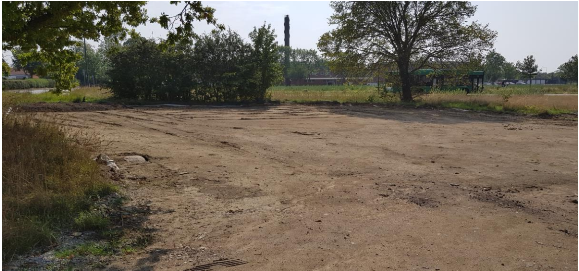
Figur 5.4 visar pågående utläggning av återfyllningsmaterial.
