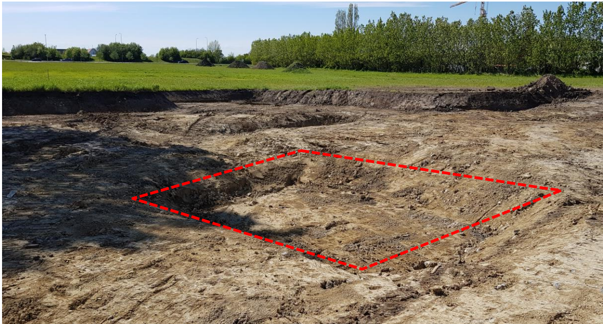
Figur 5.1 visar vy mot nordväst. Ren schaktbotten. Röd streckad linje/tidigare källare med avfall.
