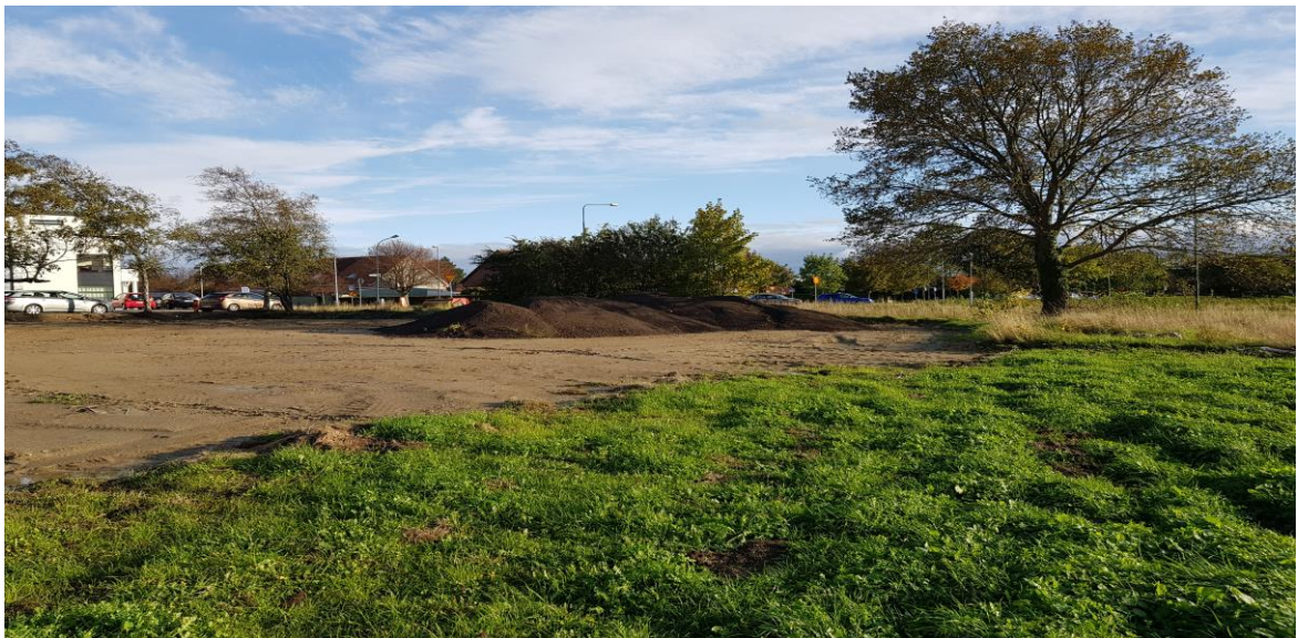
Figur 5.6 visar pågående utläggning av utjämningskikt av siktad grusig matjord.
