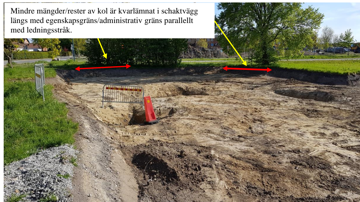
Figur 5.2 visar vy mot sydväst. Ren schaktbotten. Röd linje visar schaktvägg med rester av bl.a. kol.
