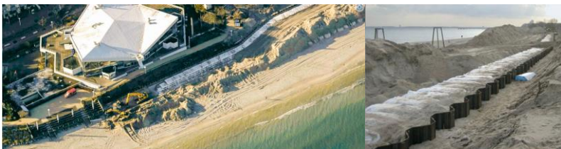
Figur 23. Bild från anläggningsskedet för en delsträcka av det integrerade kust- och översvämningsskyddet i Scharbeutz (bilder från företaget som producerar tekniska komponenter (Naue Secutex, 2023b)). Den totala längden av kustavsnittet som skyddats med denna teknik uppgår till totalt 5,4 km.
