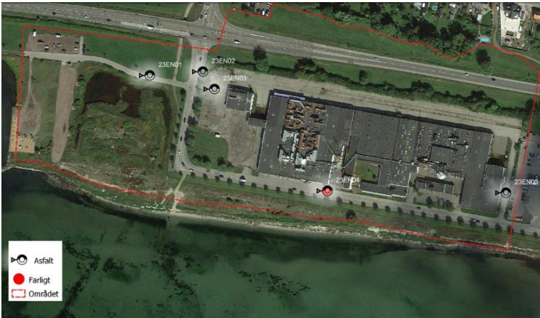
Figur 130. Bild från (Awer Geoteknik, 2023b). Uttagna asfaltprover (grå markeringar) i området och prov 23EN04 (röd markering) där halterna överskred värdet (300 mg/kg TS) för att klassas som tjärasfalt.
