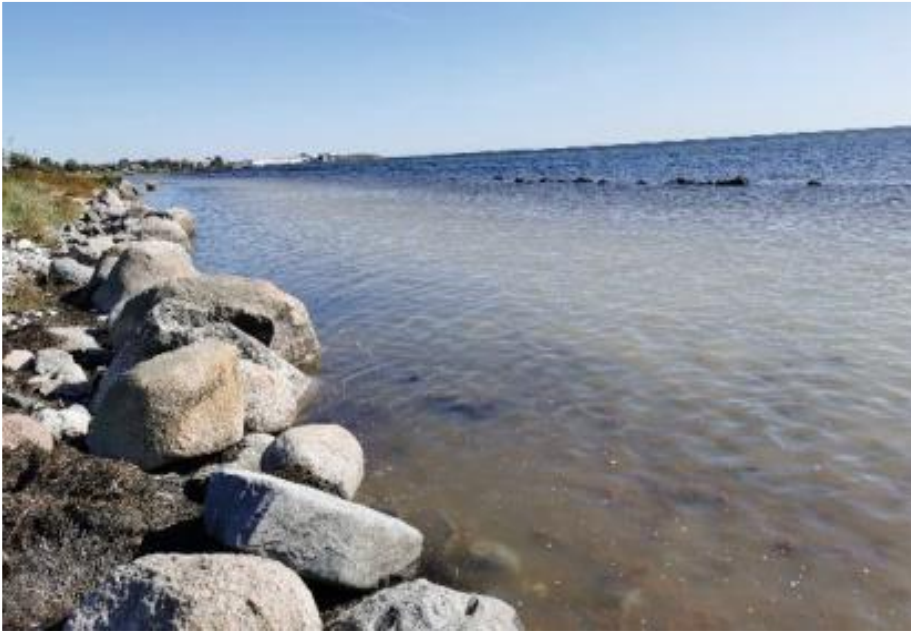
Figur 15. Erosionsskydd och stenrader i vattnet. Bildkälla: Sweco
