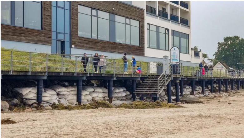
Figur 22. Anläggningen i Scharbeutz fotograferad direkt efter stormen Babet i oktober 2023 (bilder från företaget som producerar tekniska komponenter (Naue Secutex, 2023a)). Översvämningsskyddets erosionskydd (sandstrand) har delvis spolats bort och frilagt den underliggande tekniska konstruktionen (så kallade soft-rock-sandcontainers) som stått kvar och fungerat som högvattenskydd under högvattenhändelsen. Stormen Babet medförde rekordhöga vattenstånd utmed den berörda delen av den tyska kusten.
