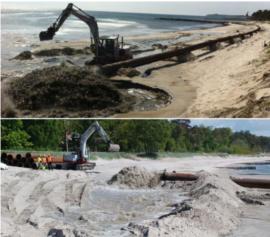
Figur 25. Strandfodring med rörledning från fartyg i Ystad. Källa: (Sweco, 2013).
