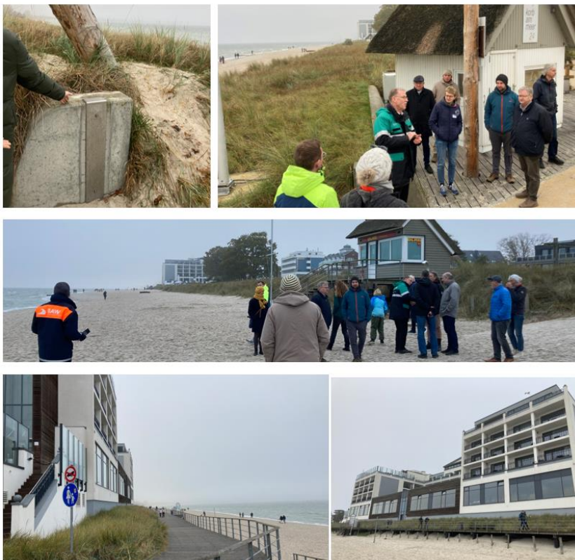
Figur 21. a-f. (Foto: Emanuel Schmidt, Sweco). Bilder tagna under en exkursion i samband med konferensen The 150th Memorial Conference Baltic Storm Surge 1872 i Tyskland, oktober 2022. Bilderna visar ett kombinerat skydd, där ett översvämningsskydd är inbyggt i den gräsklädda delen av stranden, alltså döljs i ett anlagt dynsystem som regelbundet underhålls genom strandfodring. I anslutning till strandens övre del, i höjd med krönet av översvämningsskyddet finns ett gångstråk för passage framför den strandnära bebyggelsen. Höjdryggen är vid vissa ställen öppen för passage ner till stranden, men kan stängas vid behov när vattnet stiger.
