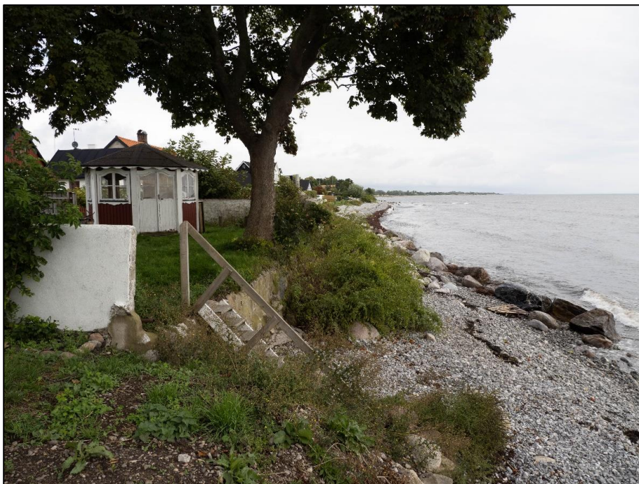
Figur 4-1 Strandkanten vid den värst drabbade sträckan. I förgrunden syns hur jordmassor har tillförts för att skydda en tomt. Strandplanet är mycket smalt här, endast ett par meter.
