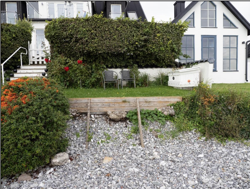
Figur 4-4 Ett skydd av trä har uppförts för att skydda erosionsbranten vid ett stycke tomt framför en fastighet.
