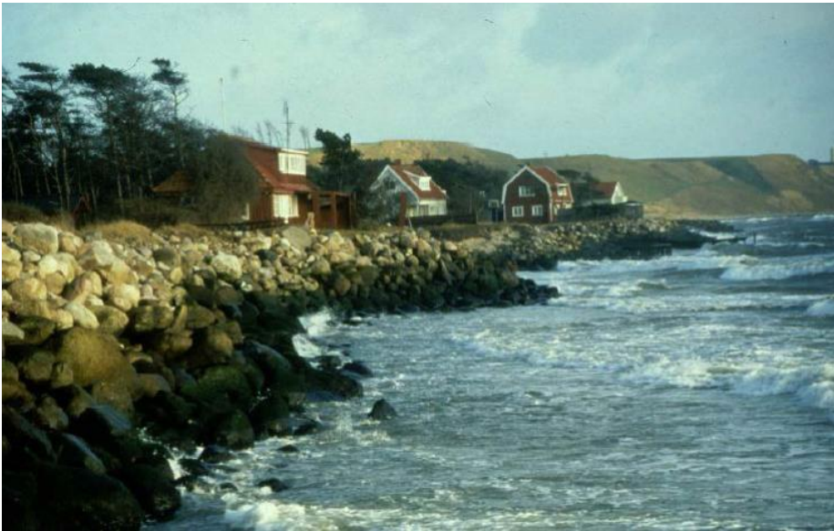
Figur 3-5 Strandskoning med natursten vid Löderups strandbad.
