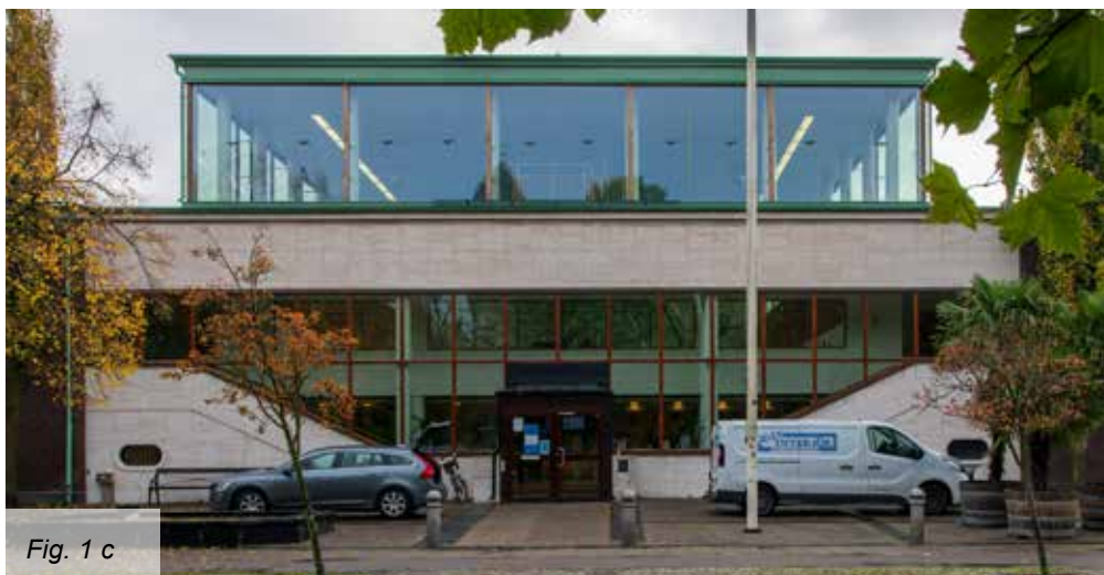
Fig. 1 - q1 Skyddsbestämmelser för badhuset, exteriört, anger att volym, fönster- och dörsättning (fig. 1 c), material såsom travertinmarmor (fig. 1 b) och helsingborgstegel (fig. 1 a) samt ursprungliga fönster- och dörrpartier (fig. 1 c) ska bevaras.
