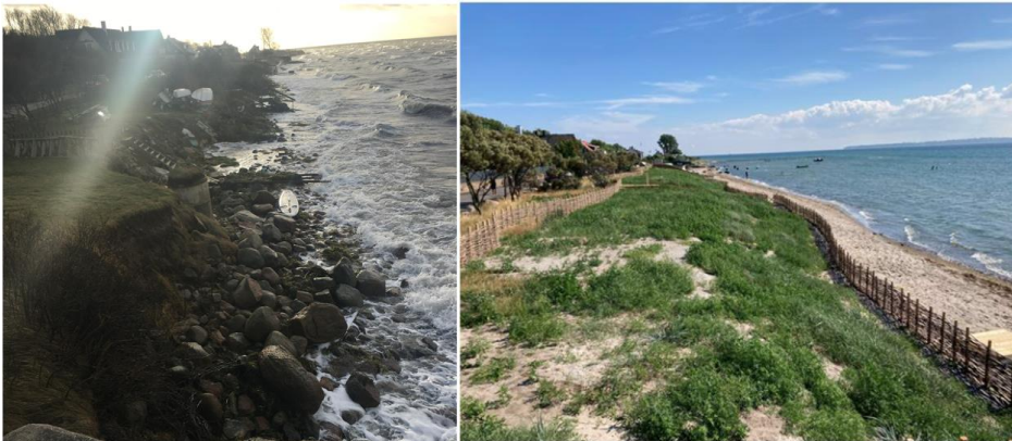
Figur 16. Småskalig kombinerad stand- och dynfodring vid Fortuna strand, Helsingborg kommun. Bilden t.v. visar stranden före åtgärderna, under storm, och bilden t.h. visar efter åtgärderna genomförts.
