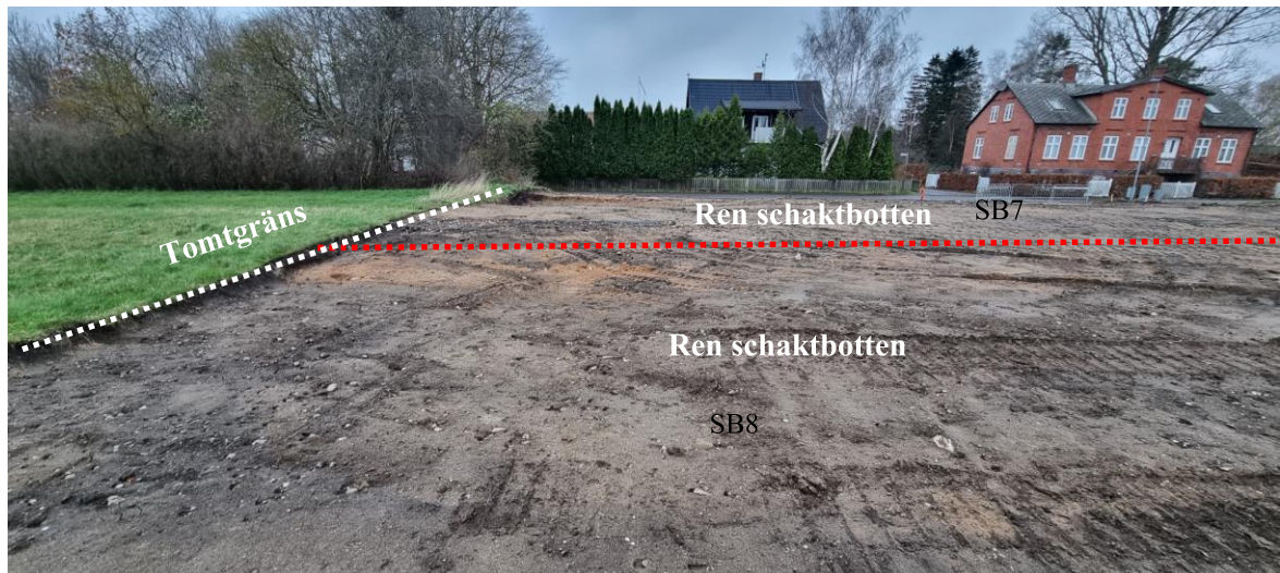
Figur 5.2 visar sanerad schaktyta. Området uppdelat i schaktbotten 7 respektive 8. Röd streckad linje, ungefärlig fördelning mellan rutor. Vy mot väst.
