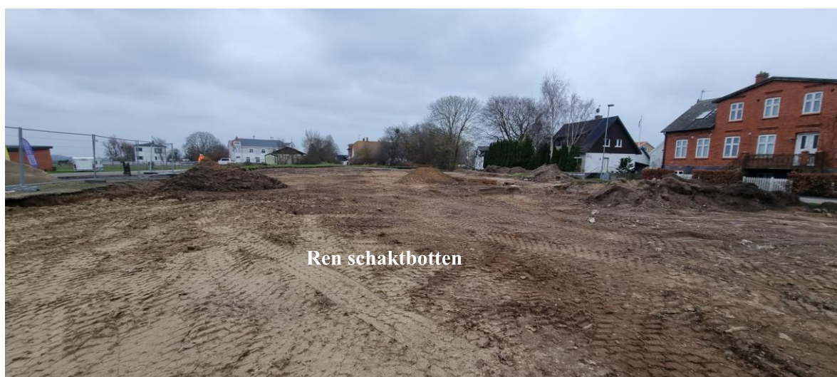
Figur 5.4 visar sanerad yta. Samtliga schakthögar bortkörda. Området uppdelat i flera delytor. Vy mot söder.
