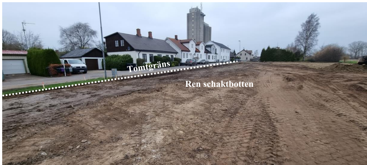
Figur 5.3 visar sanerad schaktyta. Området uppdelat i flera delytor. Vy mot norr.
