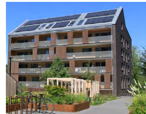
Norra Djurgårdsstaden, kv Hornslandet, foto: Stockholms stad
