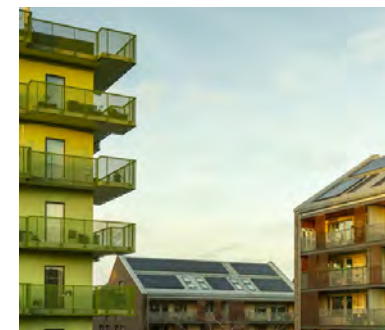
Norra Djurgårdsstaden, foto: Eric Cung Dinh
