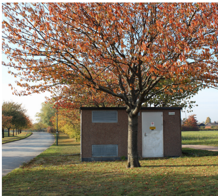
Bild tagen vid Vindarnas väg (intill nätstationen) mot väst.
