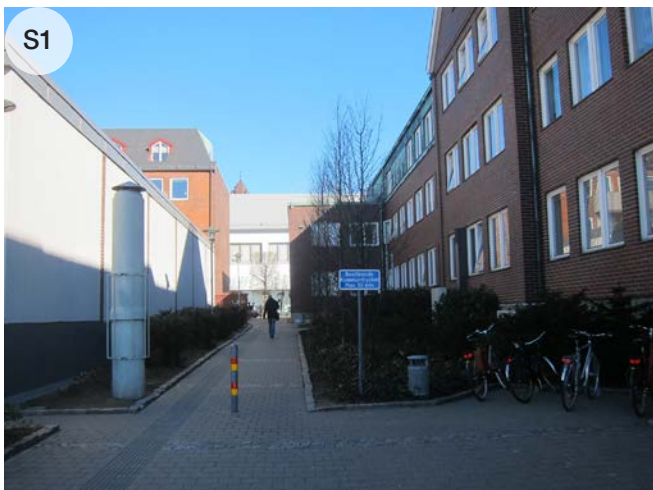
"Släppan" mellan Lindex och Rådhuset upplevs otrygg med fönsterlös fasad respektive tomt hus efter kontorstid, avslutas i söder i en parkeringsplats utan gångstråk.
