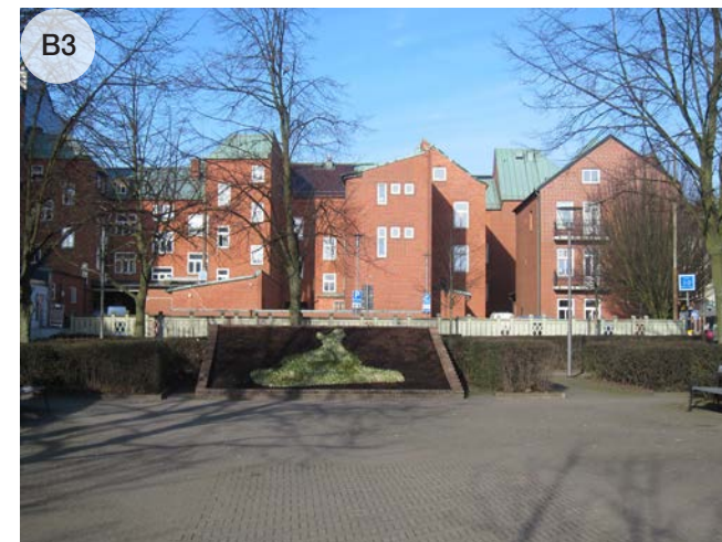
Trelleborgshems spännande gavlar med fina tegeldetaljer. Bostadsgården föreslås slutas med bebyggelse i 3 våningar - som ansluter till Garvaregårdens skala.
