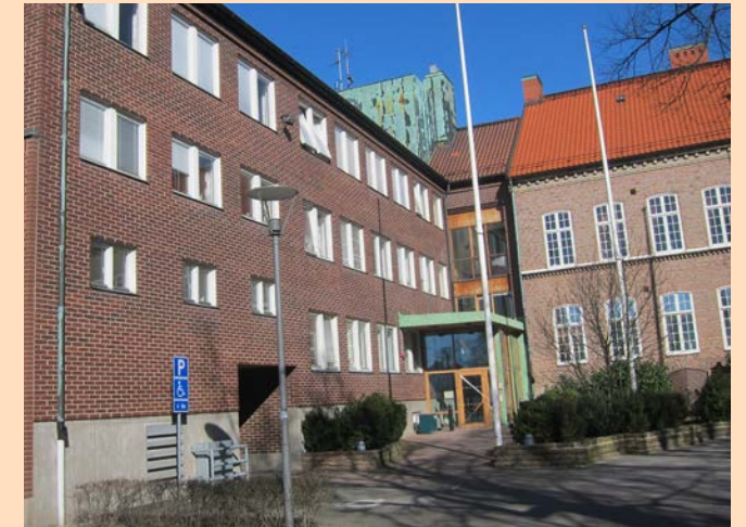
Västra flygeln föreslås rivs. Ny byggnadskropp placeras så att en ny attraktiv och tillgänglighetsanpassad passage skapas mellan Centralstationen och Algatan. Byggnaden utformas med ett aktivt tillgängligt bottenplan.
