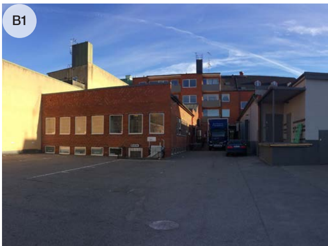
Lindex lastkaj sett från Hamngatan. Bostäder en trappa upp har en fin terrass ovan lagerlokalen. Parkeringsplatserna i förgrunden föreslås "kläs in i grönskande väggar och tak att vistas på.
