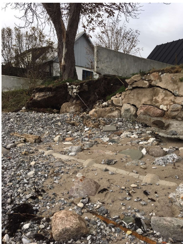
Figur 13-2 Strandområdet, spillvattenledning som flyttats
