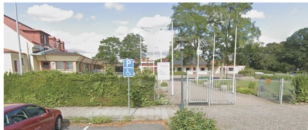
I samband med byggnationen kommer den befintliga entrén från Allén att försvinna.
