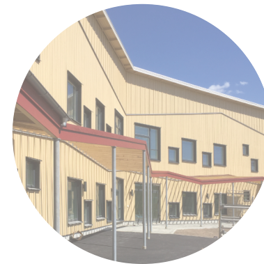
Järvastadensskola Hus 3, Solna. 2018 Förskola för 240 barn, 12 avdelningar, BTA 2230 m 2 Beställare: Hemsö Uppdragsgivare: OP2
