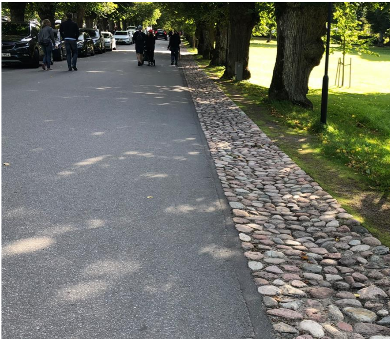
Figur 23. Exempel på stensatt dike vid väg (Tyréns AB).
