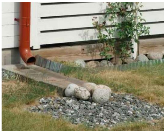
Figur 13. Stuprörutkastare med rännalsplattor med erosionsskydd som leder ut vattnet på gräsmatta. Foto: Dagvattenhandboken Haninge kommun 2019.
