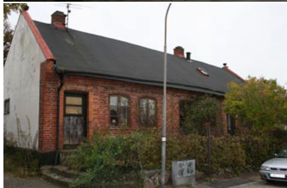
Ovan: Gatehus på Östergatan.
