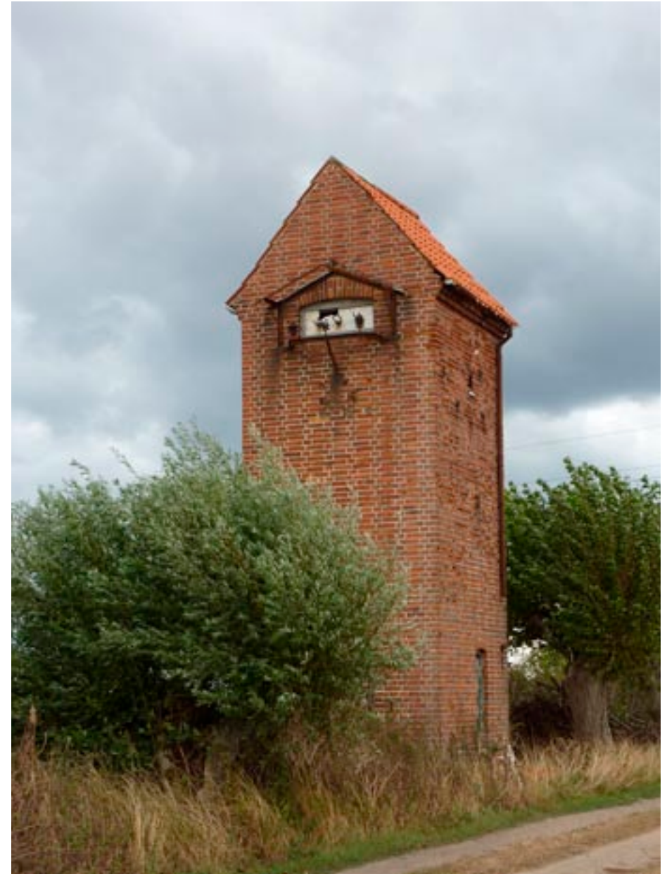
Transformatorstation vid Hemmesdynge.
