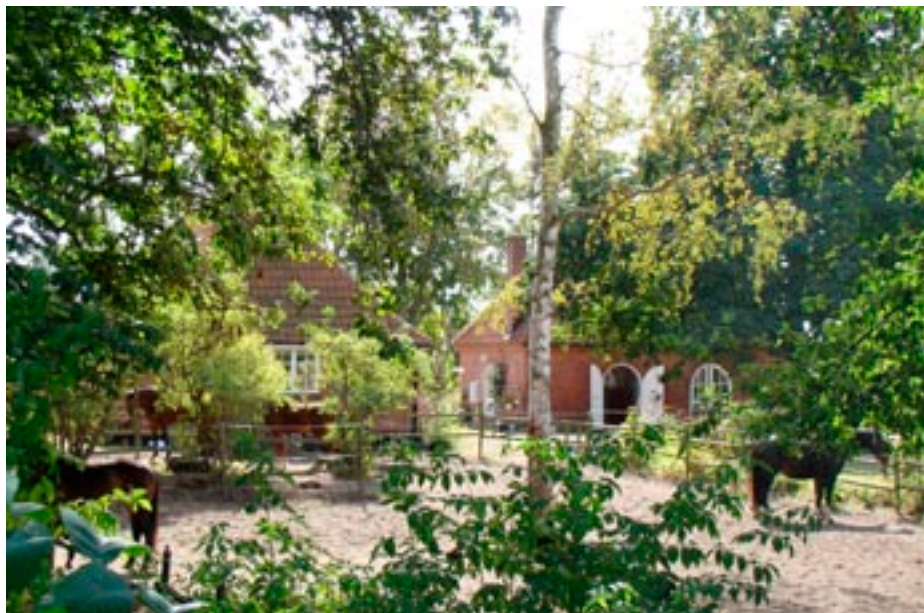
Gamla pumphuset ligger inbäddat i grönskan på botten av Dalköpingeåns dalgång.
