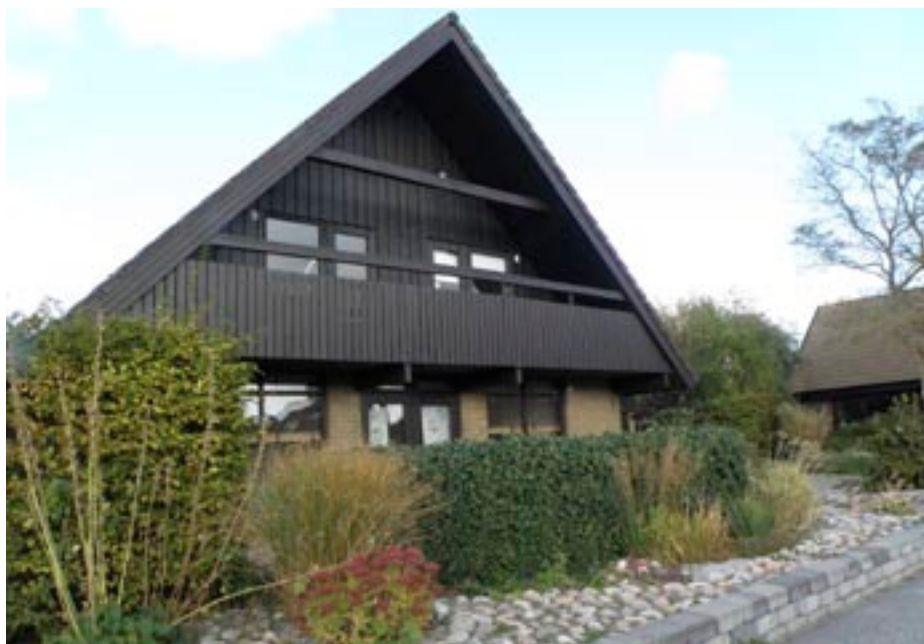
Indragen balkong på gavel, en tidstypisk 1970-talsdetalj
