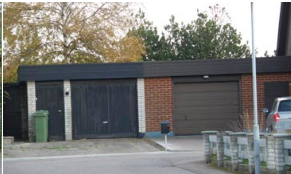
Garage med sargtak.
