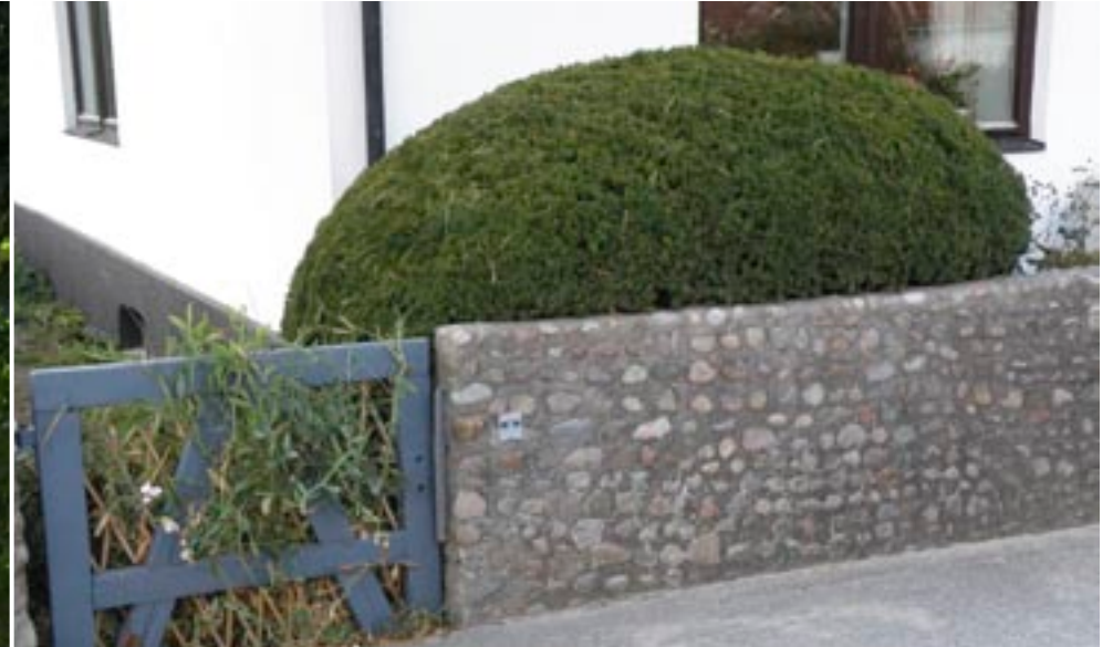
Mur med småsten
