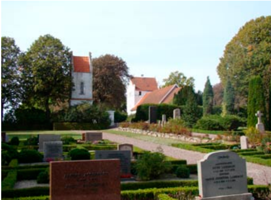
Transformatorstationen till vänster vid kyrkogården i Gylle är förvillande lik ett kyrktorn.
